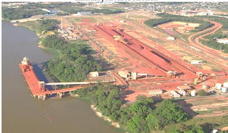
Figura 62 - Visão panorâmica do porto de embarque da bauxita minerada pela Alcoa em Juruti
