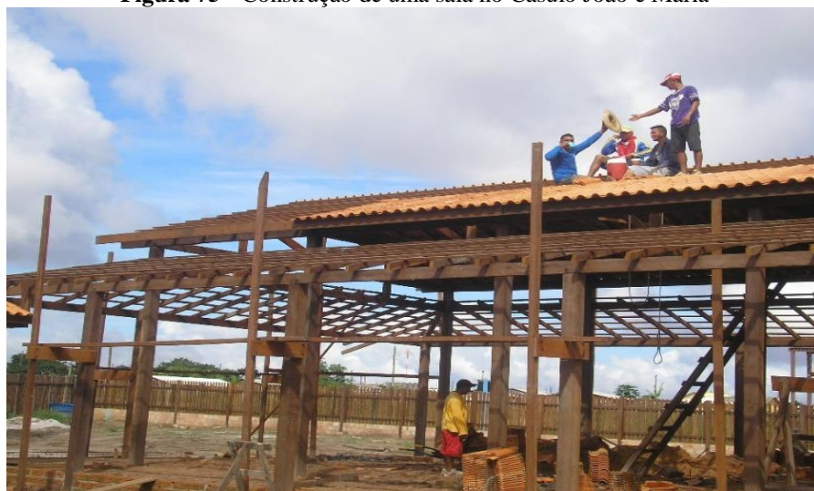
Figura 75 - Construção de uma sala no Casulo João e Maria
