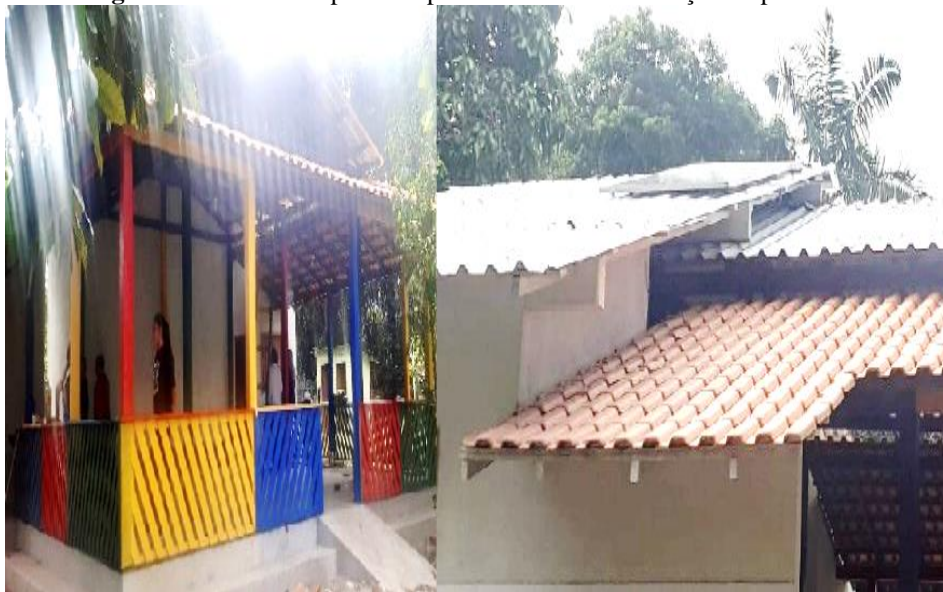
Figura 74 - Casulo Capelinha após reforma com instalação de placa solar
