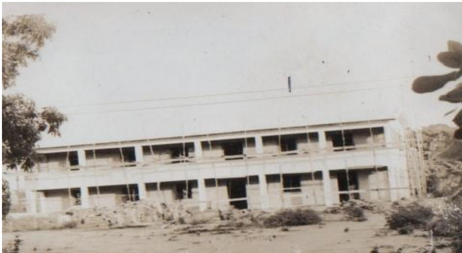
Figura 4 - Construção do ambulatório e residência das freiras em 1965 - Casa Samaritana
