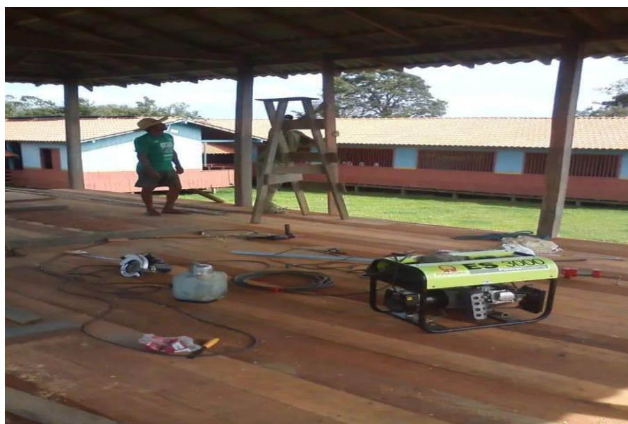
Figura 9: Construção do espaço para funcionamento do PME
