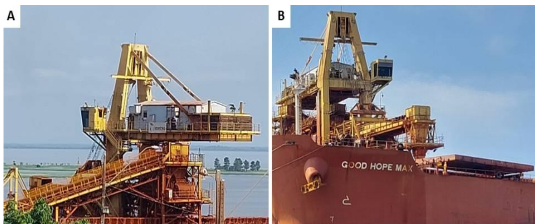
Figura 23 - Carregador de navio. A) Parte lateral do carregador B) Porão sendo carregado
