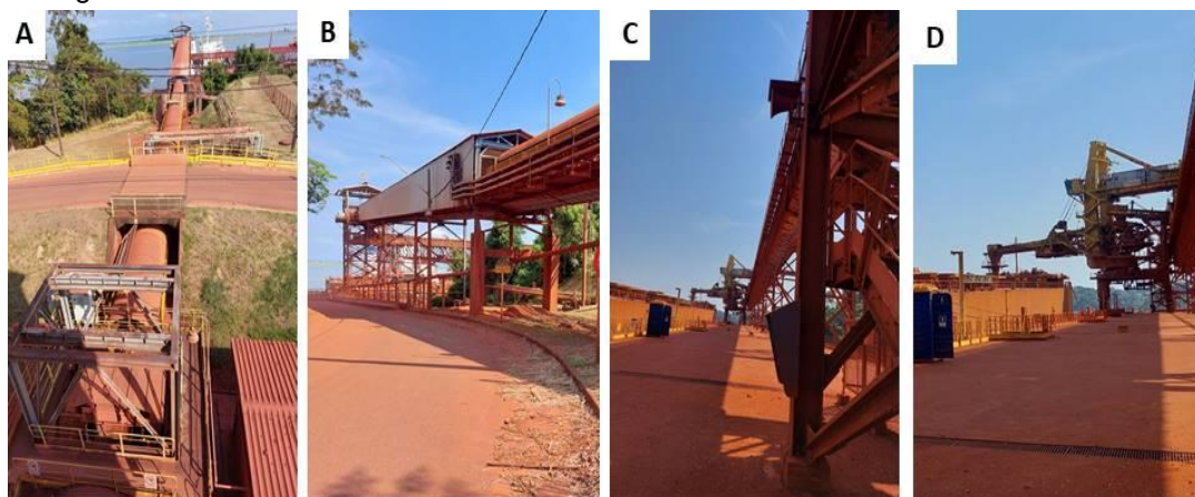
Figura 22 - Torre de transferência TP002 e CAT002. A) Material passando pela TP002. B) Material chegando na CAT002. C) Material seguindo na correia. D) Material chegando ao carregador de navio
