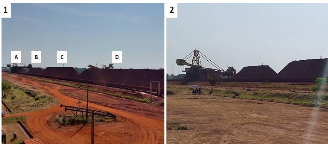
Figura 14 - Pátio de minério de bauxita do porto. 1) Pilhas A, B, C e D. 2) Capacidade de cada pilha entre 55 e 59 toneladas
