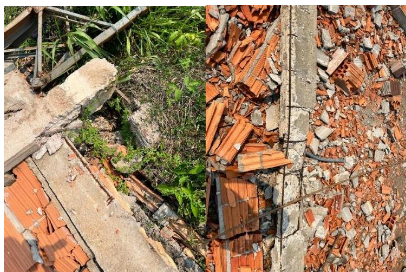
Figura 12:Viga e Pilar do Galpão
