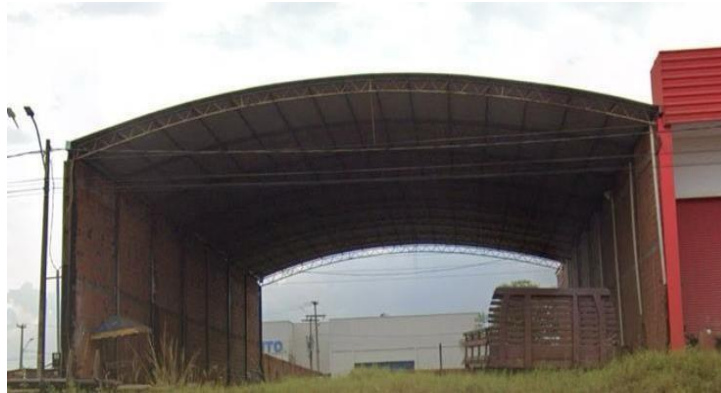
Figura 4: Galpão antes do acidente.
