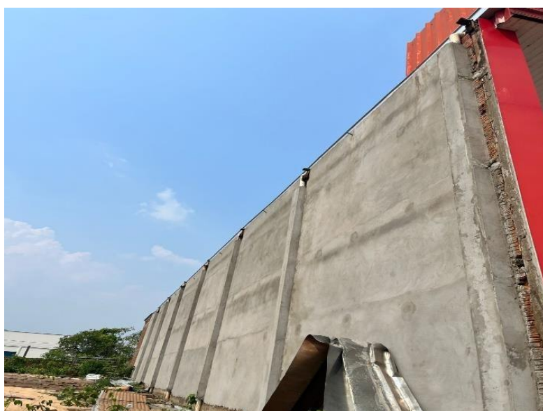
Figura 13: Estrutura de sobre apoio.
