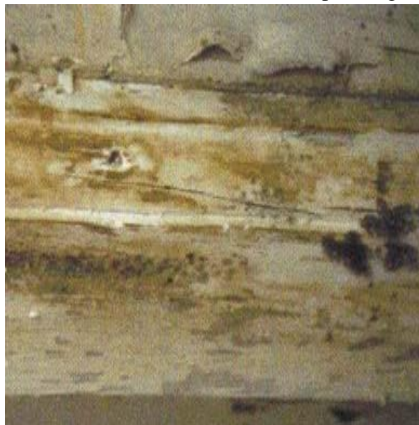
Figura 5 - Características visuais de madeira ataca por fungos emboloradores.
