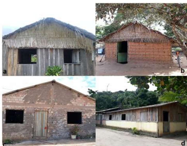
a- Habitação de madeira; b- Habitação de adobe sem revestimento; c- Habitação de alvenaria sem revestimento; d- Habitação mista.
