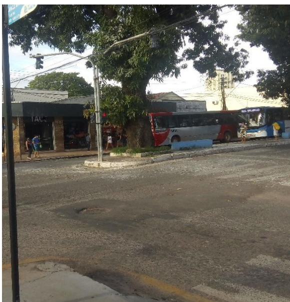
Figura 13: Faixa de pedestre obstruída por árvore e canteiro central na Av. Rui Barbosa.
