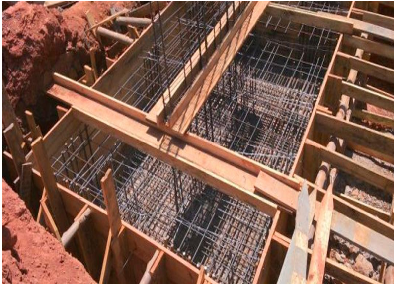
Figura 14: Fundação tipo caixão
