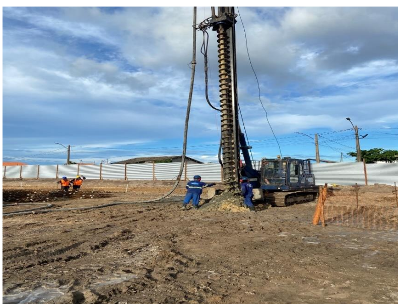
Figura 18: Perfuratriz com haste helicoidal
