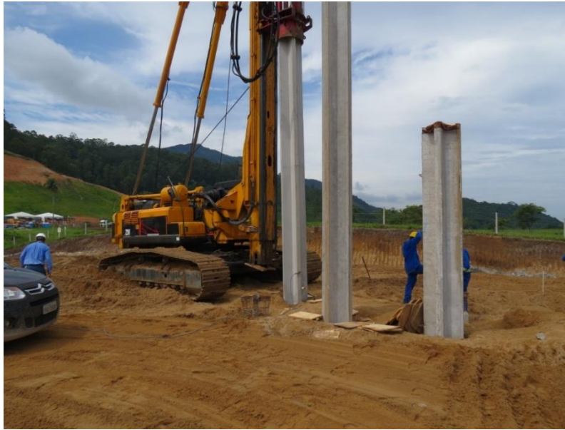
Figura 9: Estaca cravada pré-moldada de concreto
