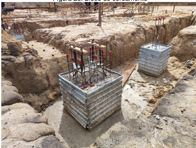
Figura 23: Bloco de coroamento
