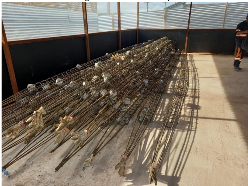
Figura 21: Estacas de aço
