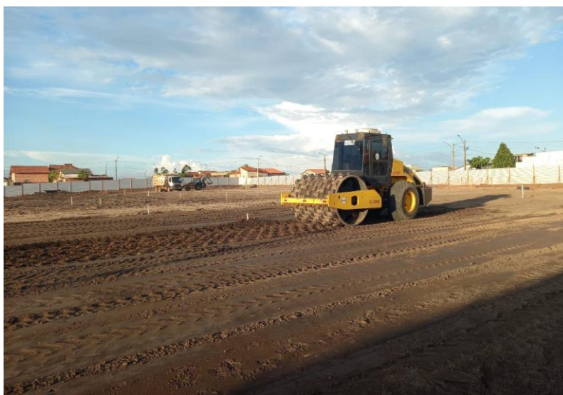
Figura 16: Compactação do terreno
