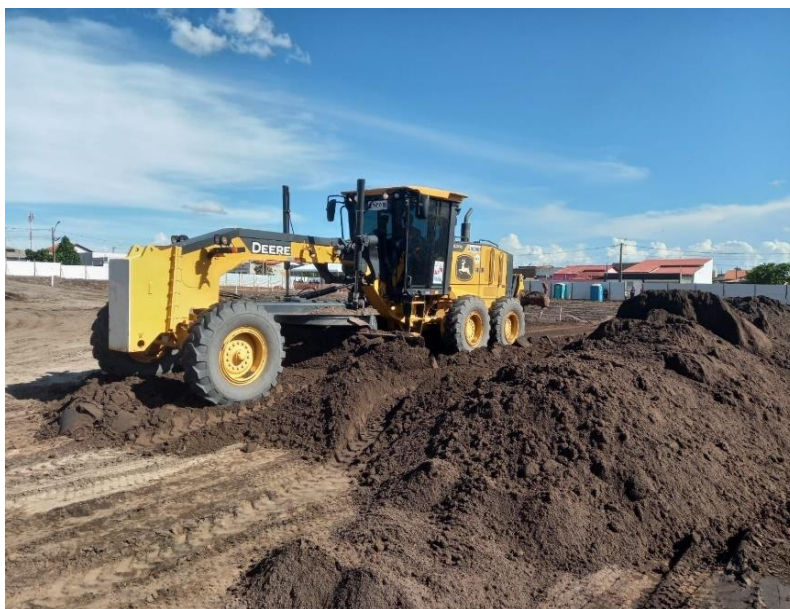
Figura 17: Nivelamento do terreno com a motoniveladora
