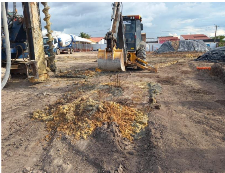
Figura 22: Arrasamento da estaca
