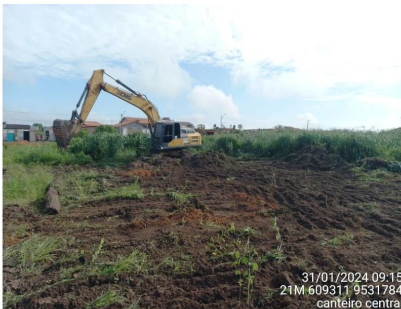
Figura 15: Limpeza do terreno com a escavadeira hidráulica
