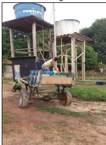
Figura 1: Micro abastecimento de água da Comunidade Nova Vitória
