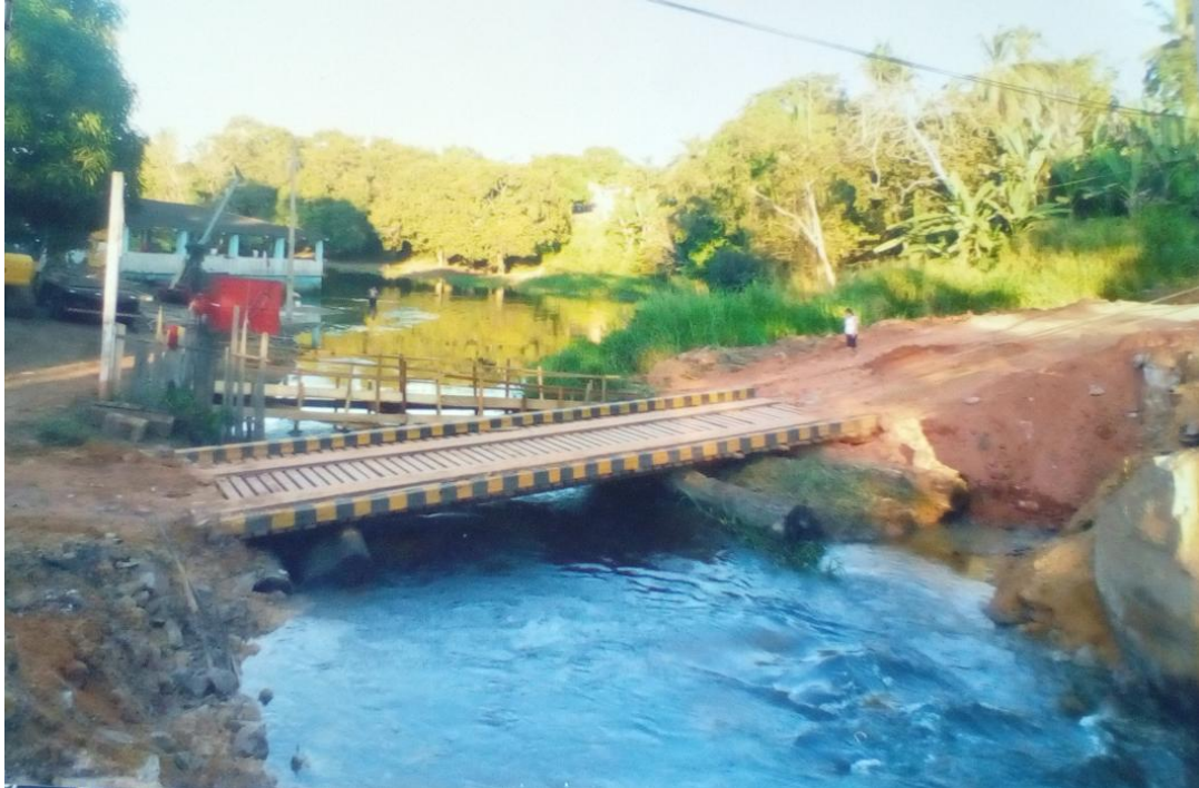
Figura 9 - Retirada da ponte de madeira que dava acesso às duas margens do igarapé.
