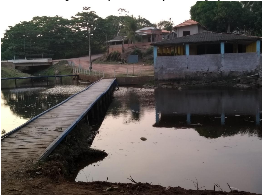
Figura 12 - Trapiche construído por cima do igarapé.
