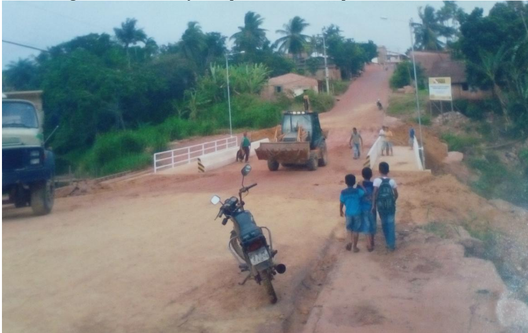
Figura10 - Substituição da ponte de madeira por uma de concreto.
