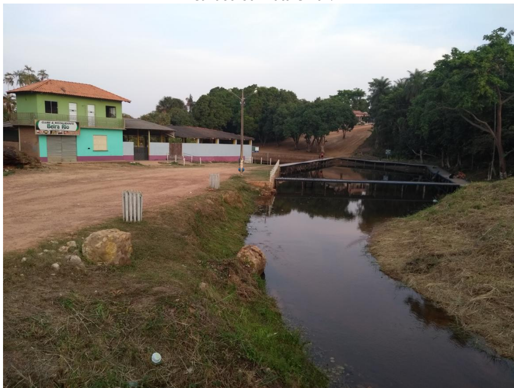
Figura4 –Observam-se construções mais elaboradas às margens do igarapé, bem como a retirada da mata ciliar.
