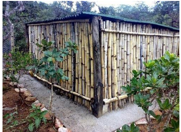
Figura 8 - Paredes feitas de bambu opção para substituir tabuas da parte frontal do aviário.
