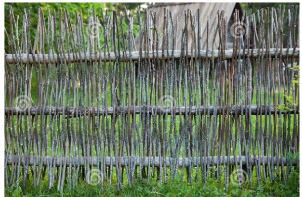
Figura 14 - Cerca trançada de vara seca, opção para substituir estacas e tela.
