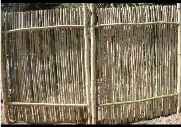
Figura 7 - Cercas de bambu para o piquete, opção para substituir estacas e tela.
