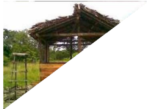
Figura 5 - Aviário caipira semiacabado construído com principalmente, com partes do açazeiro.
