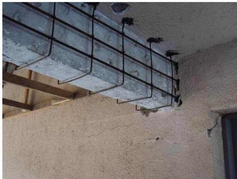
Figura 58 - Preparo de uma viga para a execução do reforço.
