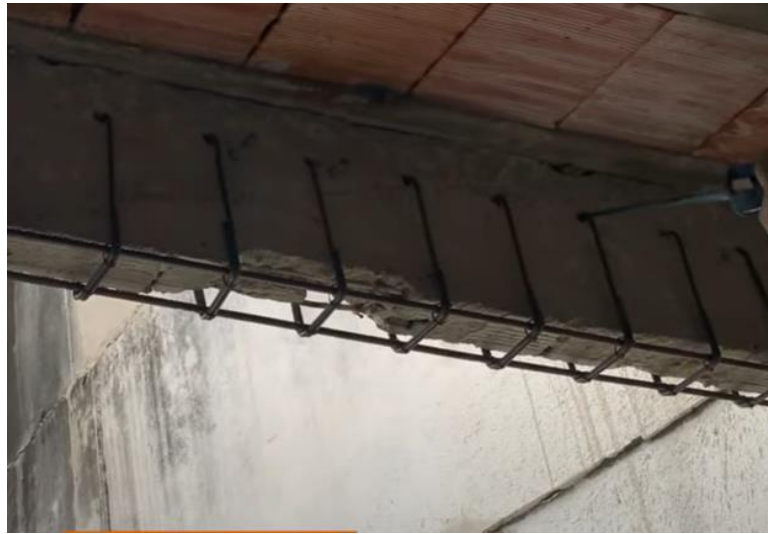
Figura 57 - Posicionamento dos estribos e armaduras longitudinais.
