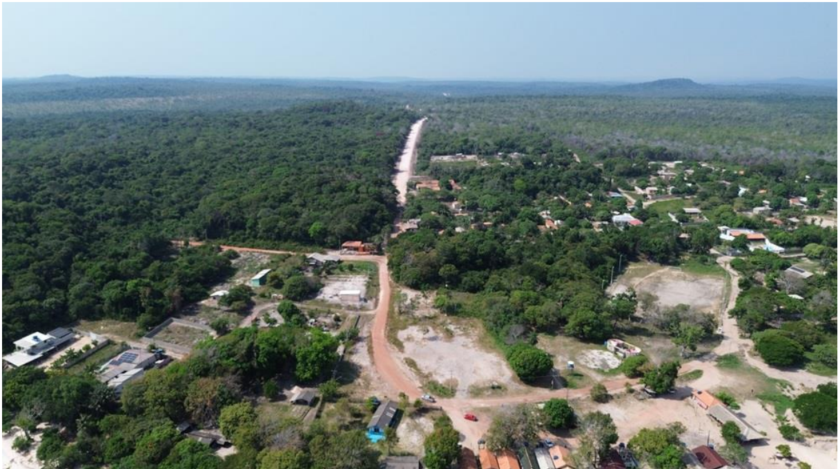
Figura 21: Tomada aérea de Ponta de Pedras com destaque para a estrada de acesso à PA-457 e a Serra do Curucuruí ao fundo, à direita. Fonte: NEPES-UFOPA.
