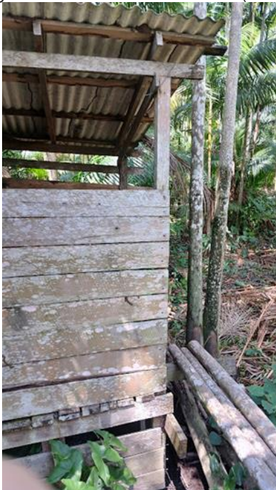
Figura 19 - Acesso ao sanitário (latrina)
