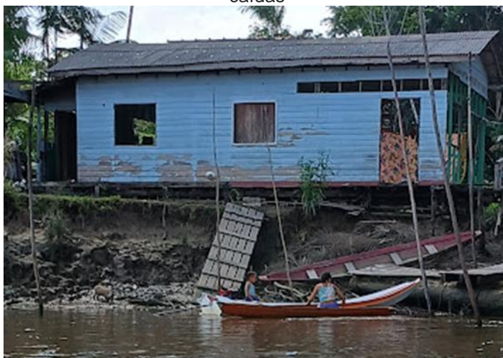
Figura 15 - Casa na beira do rio abandonada após o risco de desabamento causado pelas terras caídas
