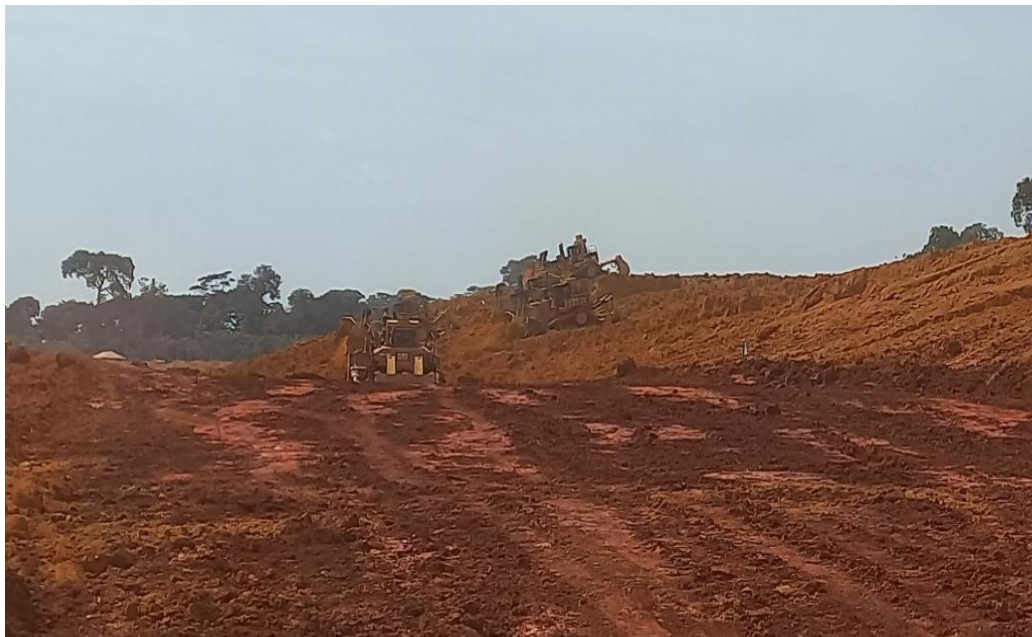
Figura 8 - Retirada da camada de laterita.
