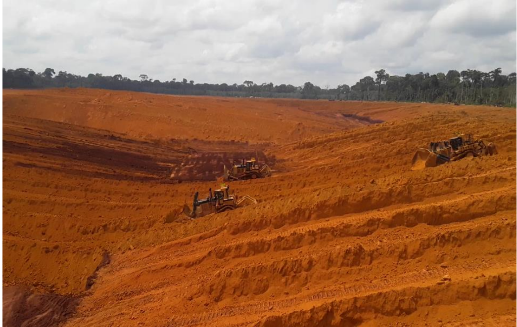
Figura 6 - Decapeamento de argila com trator de esteiras D11.
