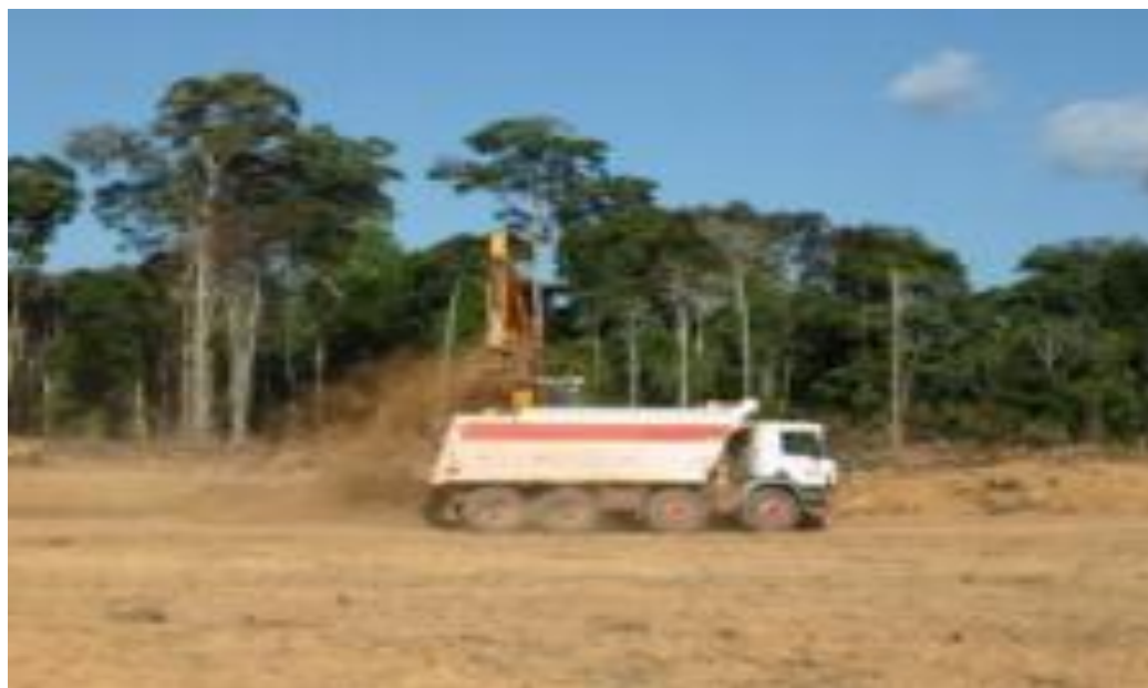
Figura 5 - Carregamento de solo orgânico.
