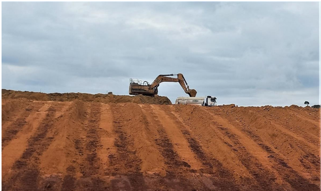
Figura 7 - Decapeamento com escavadeira hidráulica.
