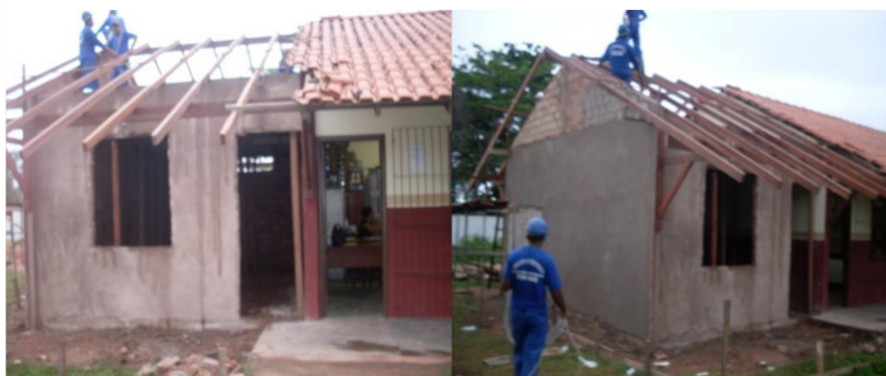
Figura 6 – A construção da sala do PROUCA
