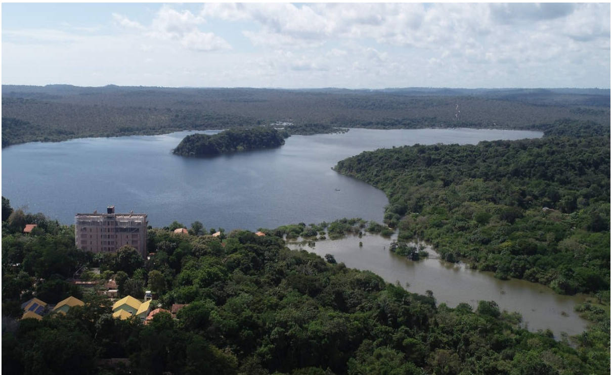
Figura 09 - Construção do Condomínio Chão de Estrelas, com 7 andares entre o Lago Verde e o Lago Carauari.
