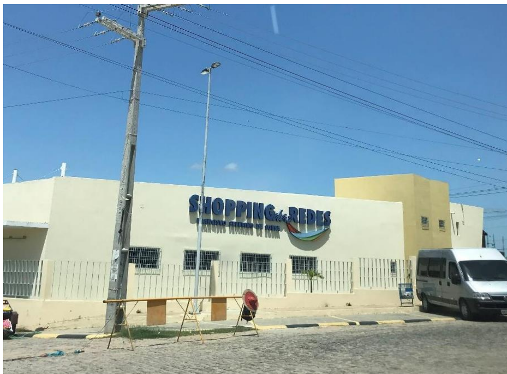
Figura 32 - Fachada do Shopping das redes Francisco Severino de Souza “o Terção”.
