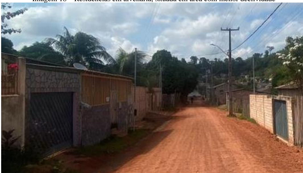
Imagem 18 – Residências em alvenaria, situada em área com menor declividade
