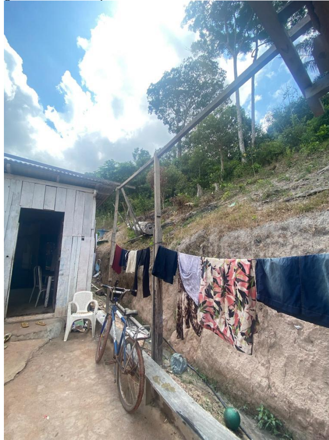
Imagem 16- Área P4, próximas a encostas e sem infraestrutura urbana.
