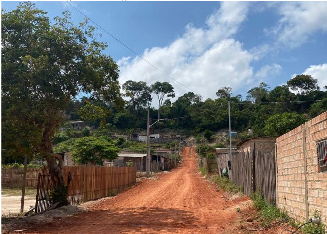
Imagem 13 - Área P4, próximas a encostas e sem infraestrutura urbana.
