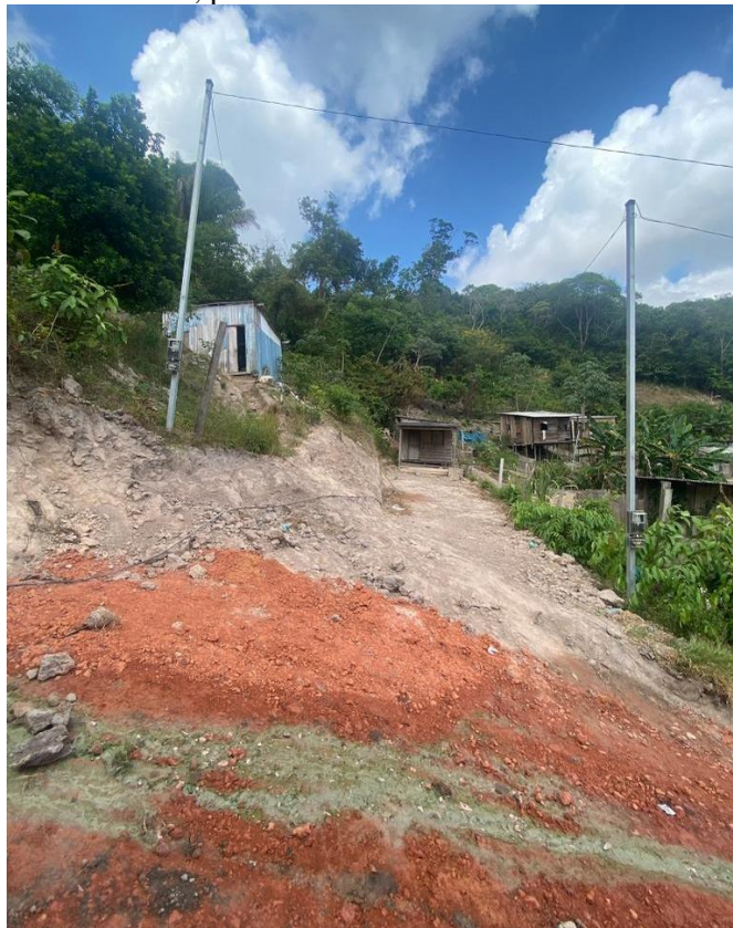
Imagem 15 – Área P4, próximas a encostas e sem infraestrutura urbana.
