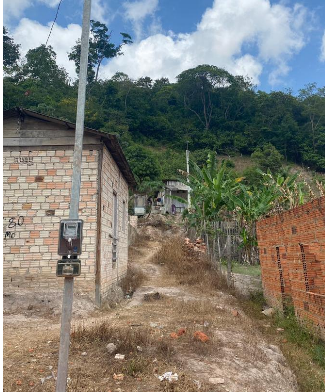
Imagem 14 - Área P4, próximas a encostas e sem infraestrutura urbana.
