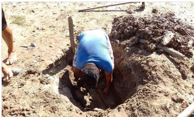
Foto 8. MANUTENÇÃO DA REDE DE DISTRIBUIÇÃO POR HOMEM DA COMUNIDADE
