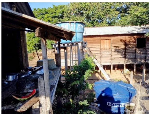
Foto 17. CAIXA D'ÁGUA SUSPensa EM UMA ESTRUTURA DE MADEIRA E SOB O CHÃO.
