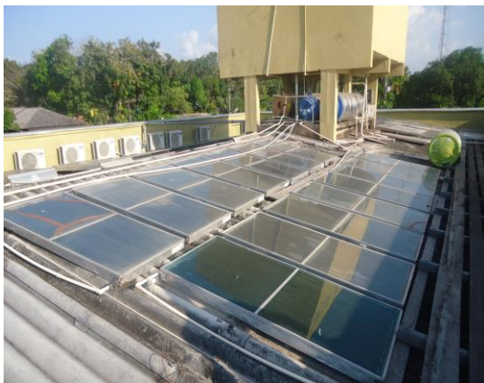
Foto 01: Aquecedor solar utilizado no Hotel B. Foto 02: equipamento do Hotel A.
