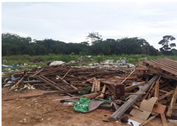
Figura 5. Área Reservada dentro do aterro do Perema para destinação de RCC's
