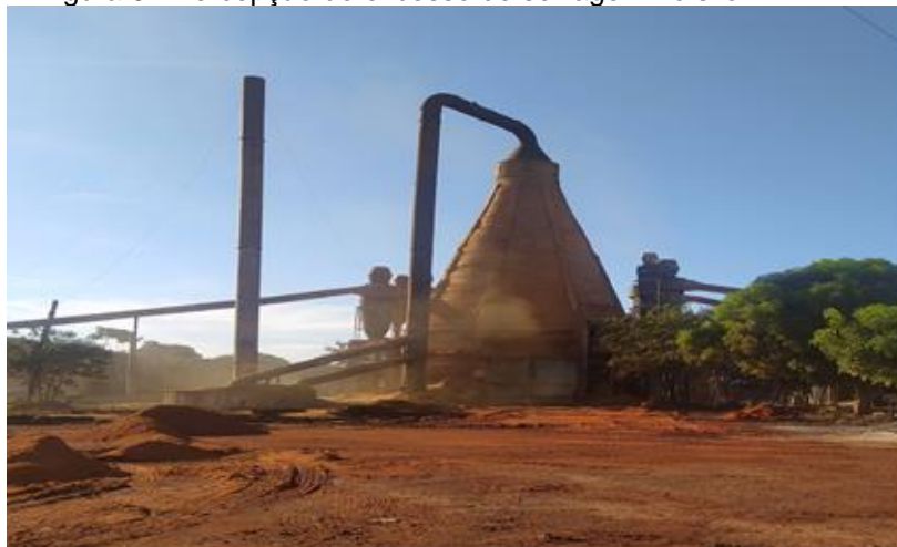
Figura 6 - Percepção do excesso de serragem no silo.
