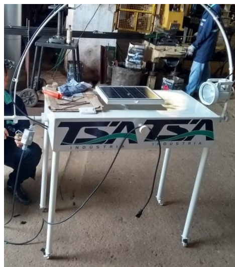
Figura 23 – Montagem das ligações elétricas da bancada e painel solar fotovoltaico.
