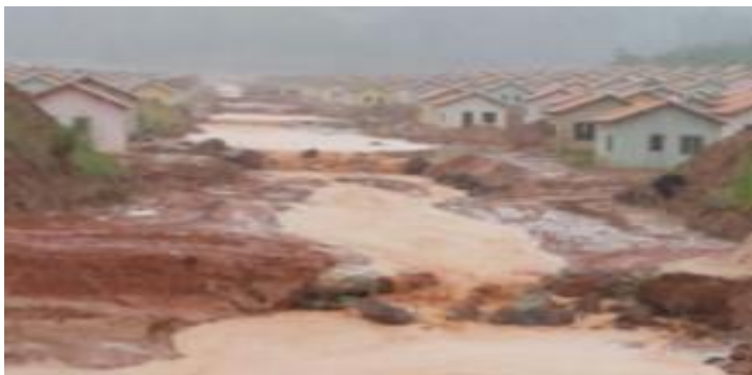
Figura 24 - escoamento de águas pluviais – Residencial Salvação, no município de Santarém, Pará, Brasil.
