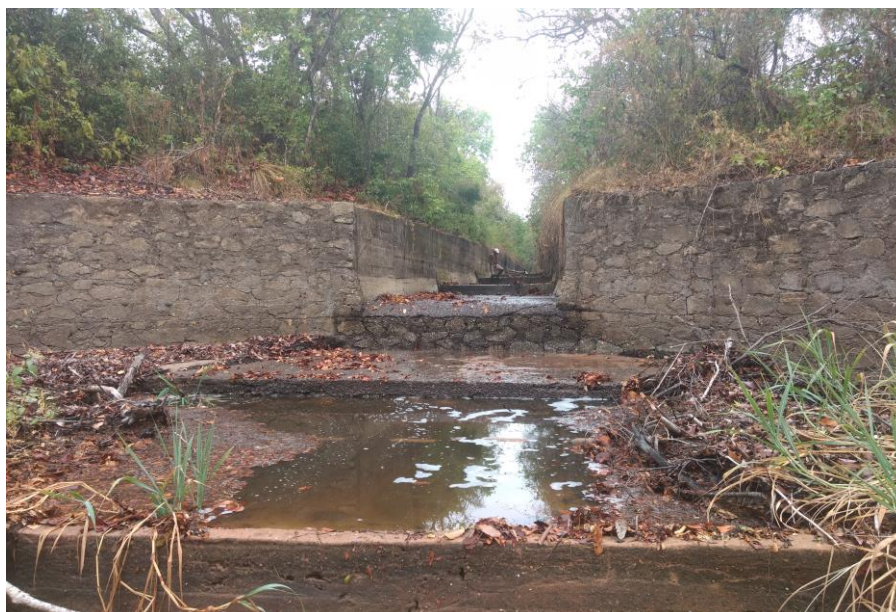
Figura 23 - Galeria do aeroporto, no município de Santarém, Pará, Brasil.
