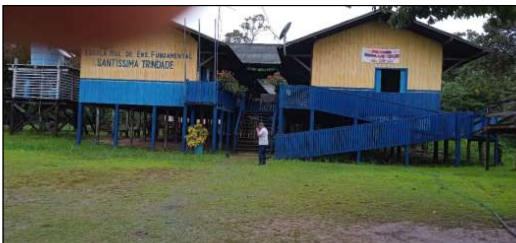
Imagem 12 – Escola Municipal Santíssima Trindade – Construção modelo palafita, 2022.
