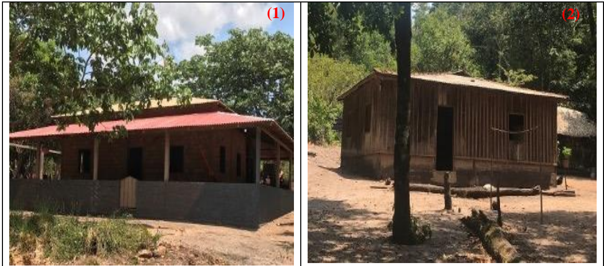
Figura 11 – (1) Moradia tipo alvenaria sem revestimento; (2) Moradia tipo madeira
