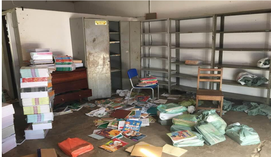
Figura 2 - Sala denominada Biblioteca antes da revitalização - 19/02/2018
