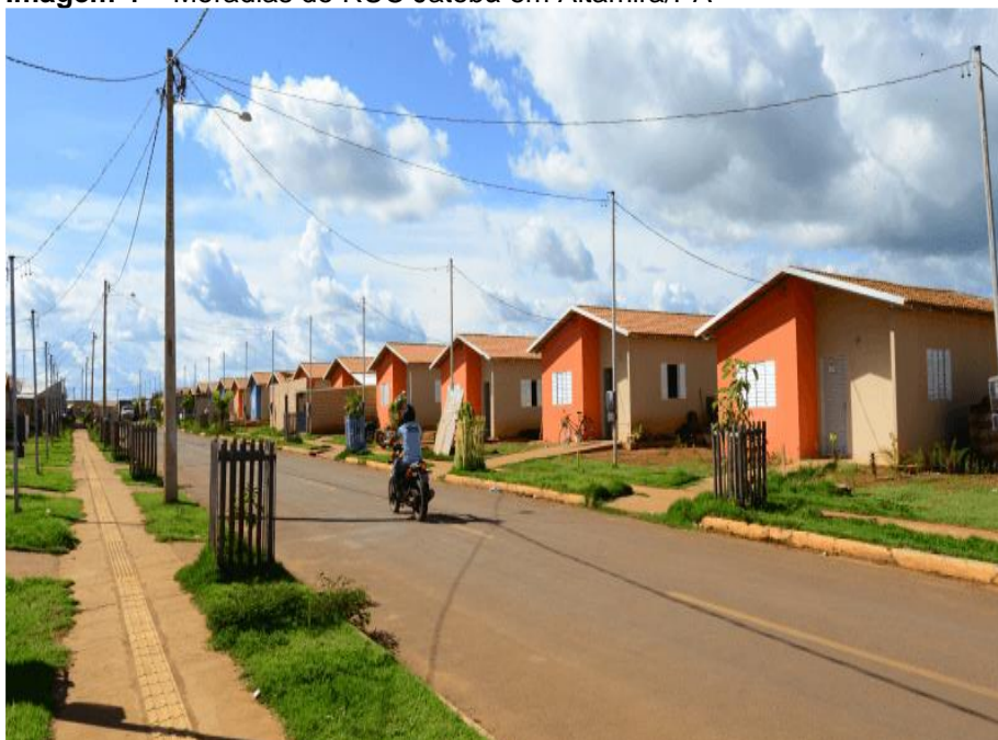
Imagem 4 – Moradias do RUC Jatobá em Altamira/PA
