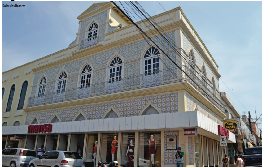
Figura 03: Solar dos Brancos – Localizado na cidade de Santarém/Pará
