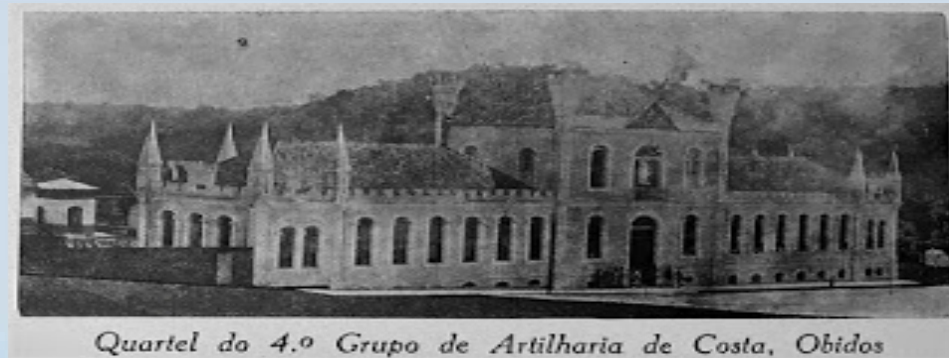
Figura 01 – Quartel de Óbidos
