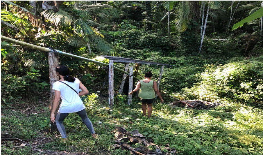
Foto 2 - Sistema de encanação bombeado da cacimba
