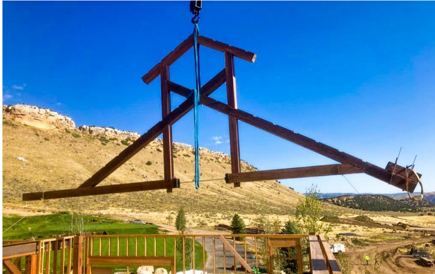
Figura 13 – Início de montagem de casa pré-fabricada no destino final.
