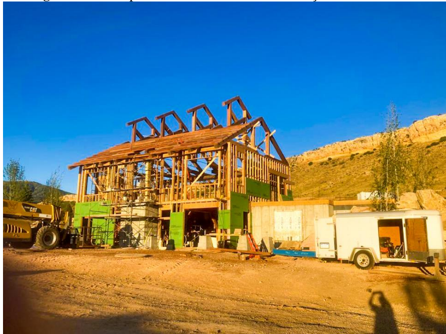
Figura 14 – Casa pré-fabricada em fase de estruturação no destino final.
