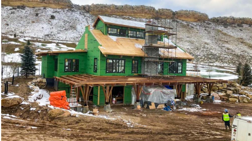
Figura 15 – Casa pré-fabricada em fase de acabamento no destino final.
