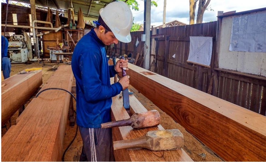
Figura 10 – Detalhes feitos com formão para acabamento de encaixe de estrutura.
