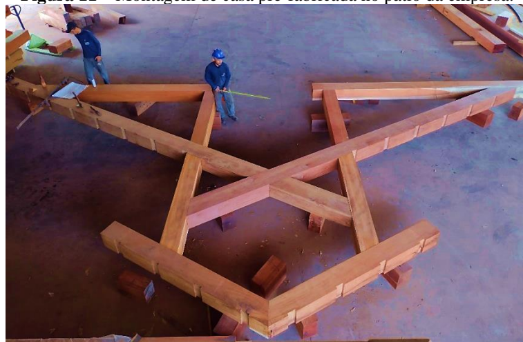
Figura 11 – Montagem de casa pré-fabricada no pátio da empresa.
