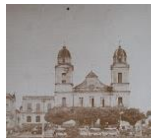
Fachada principal, 1960. Fonte: Acervo ICBS
