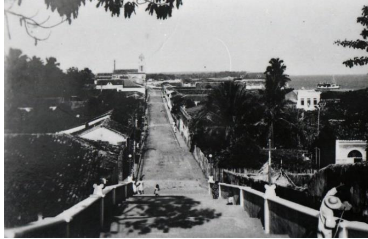
Figura 20: Ao fundo a escadaria que dava acesso ao morro da Fortaleza.
