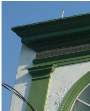
Detalhe pilastra. Fonte: Cecy Sussuarana, 2022.
