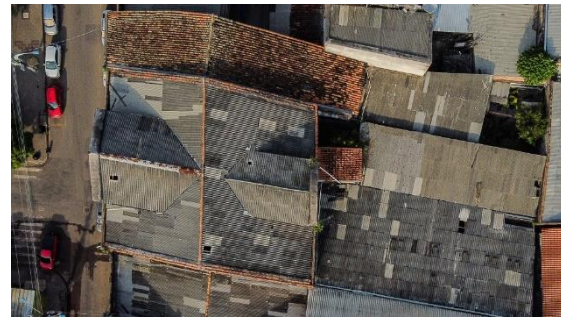
Vista superior do telhado Fonte: Manassés Lobo e Folha Filmes Produtora, 2022
