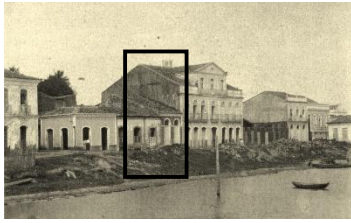
Fachada principal, sem o andar superior Fonte: ICBS
