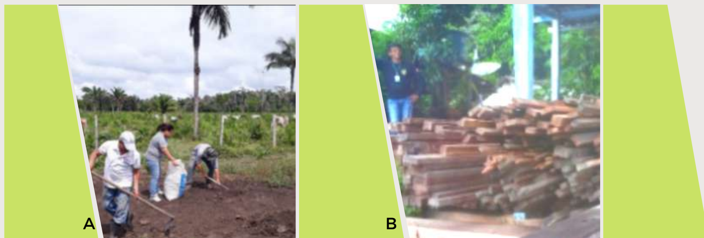
Figura 5. A - Coleta de esterco bovino de diferentes locais para construção das hortas agroecológicas. B - Material doado pela prefeitura local para construção de canteiros. Fonte: Acervo do projeto (2018).
