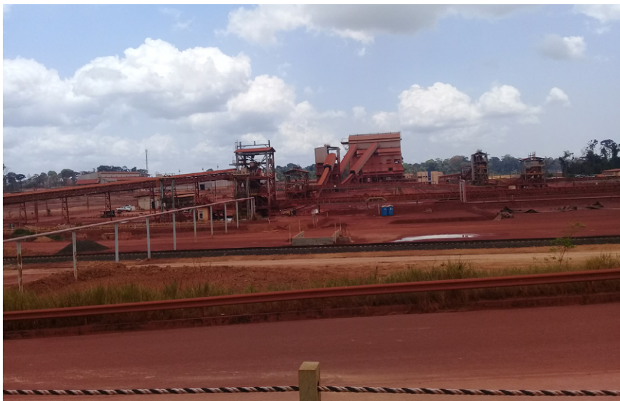
Figura 61: Planta industrial de minério da Alcoa em Juruti.
