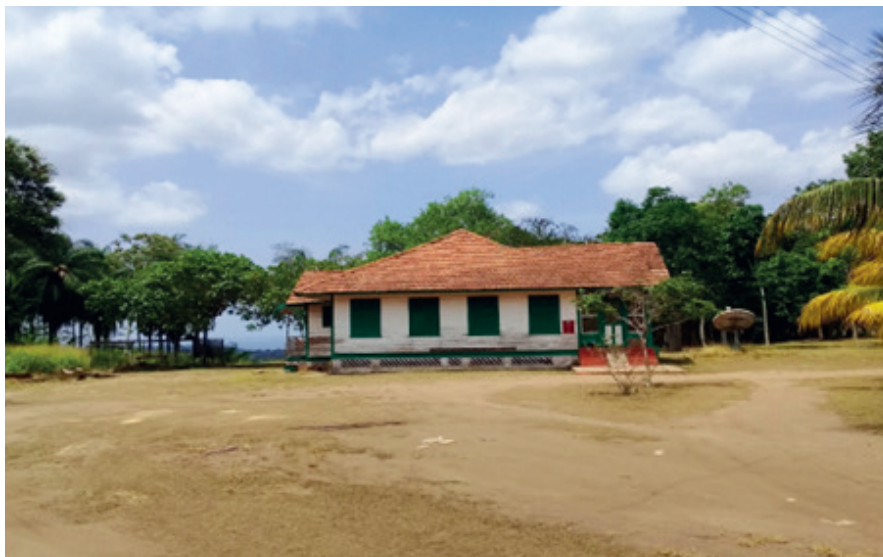
Figura 82: Casa 1 construída em Belterra para receber Henry Ford.
