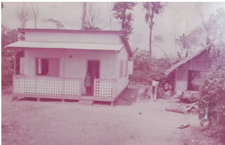
Figura 81: Casa construída pelo Projeto Integrado de Colonização em Itaituba.
