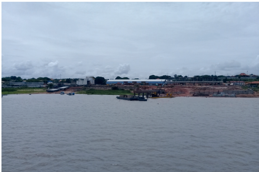
Figura 66: Aspecto do terminal hidroviário de Santarém, em construção em 2018.
