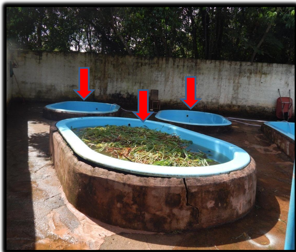
Figura 24 - Piscinas concretadas, molhadas diariamente e o sombreamento por árvores
