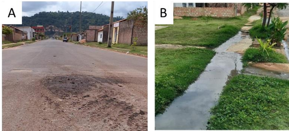
Figura 5: Retorno do esgotamento sanitário; A - Dejetos humanos na via; B - Esgoto escorrendo nas calçadas.
