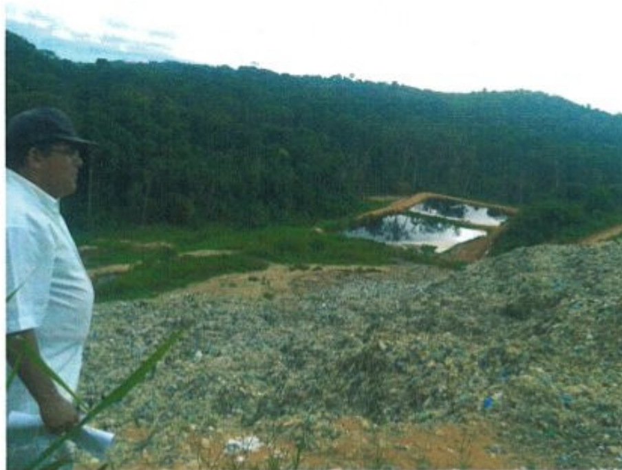
Figura 5 – Vale de lixo e lagoa de chorume. Fonte: Foto tirada pelos autores.
