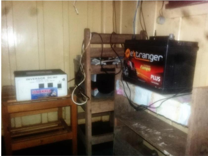
**Figura 18.** Condições de instalação dos equipamentos do sistema da escola. Fonte: Autor
