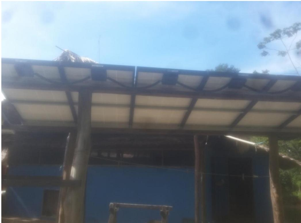
**Figura 5.** Cabeamento dos módulos fotovoltaicos instalados. Fonte: Autor
