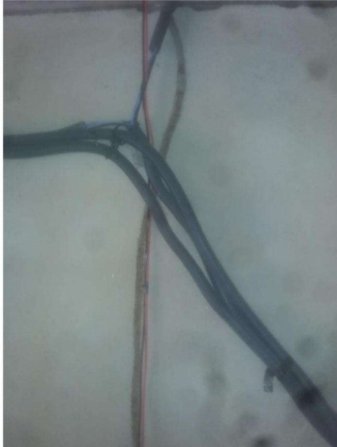
**Figura 7.** Cabeamentos expostos. Fonte: Autor
