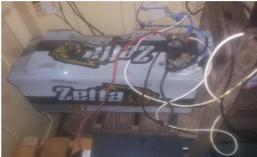
**Figura 19.** Fios elétricos expostos sobre a bateria. Fonte: Autor
