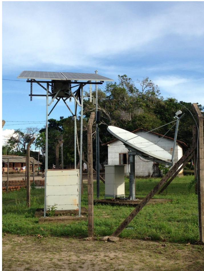
**Figura 11.** Sistema de telecomunicação fotovoltaico sem manutenção. Fonte: Autor
