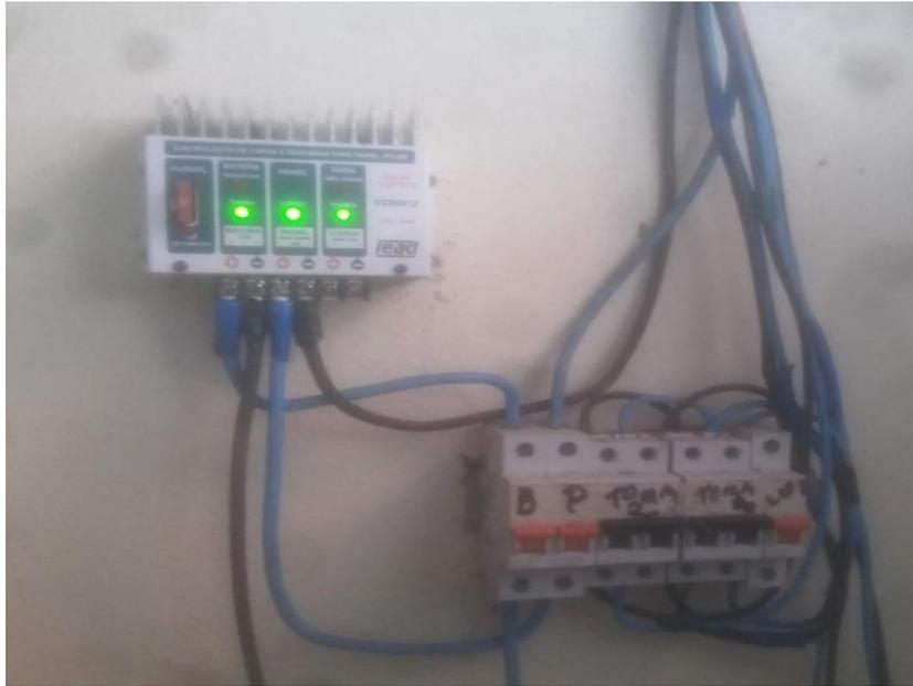
**Figura 16.** Circuitos do sistema através de disjuntores. Fonte: Autor
