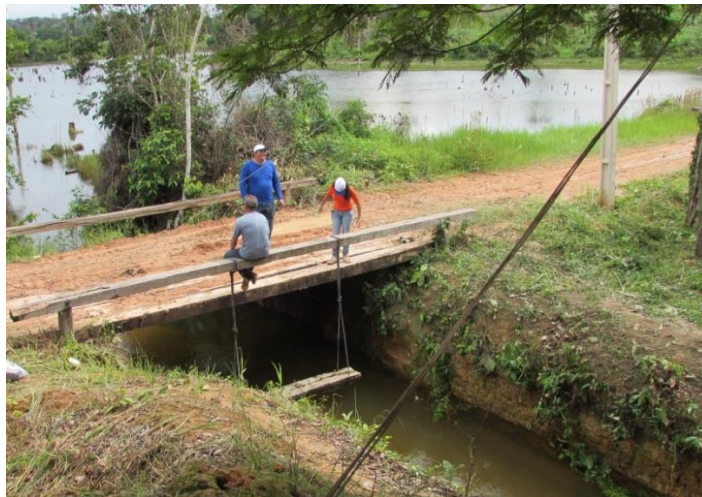
Figura 26 - Desvio do rio para a entrada do canal de adução
