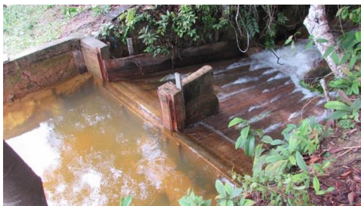
Figura 25 - Vertedouro da microcentral
