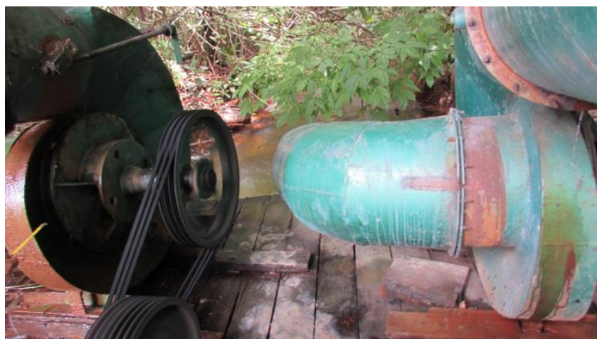
Figura 30 - Turbinas Indalma, \mu CH do Açaizal do Parta em operação
