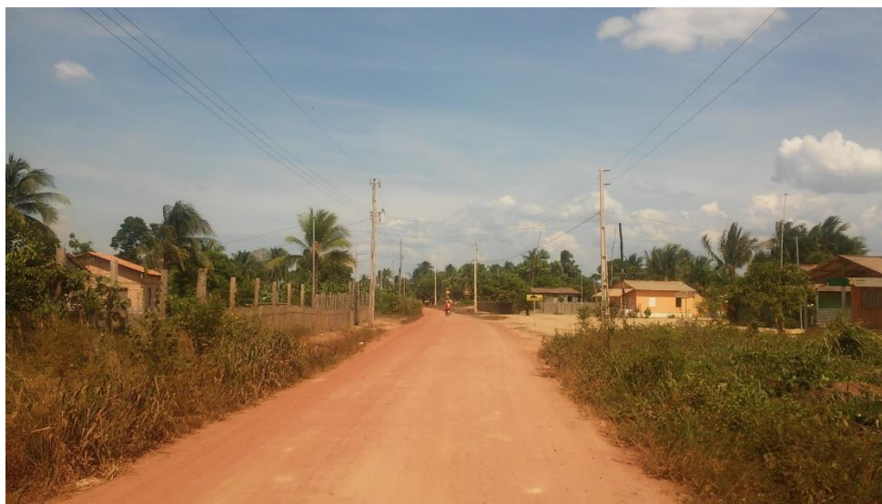
Figura 23 - Comunidade abastecida pelas redes de distribuição, CELPA e Central Geradora
