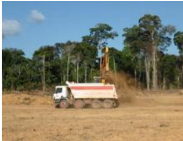
Figura 12 - Realização da retirada e carregamento de topsoil. Fonte: Amaral (2015).
