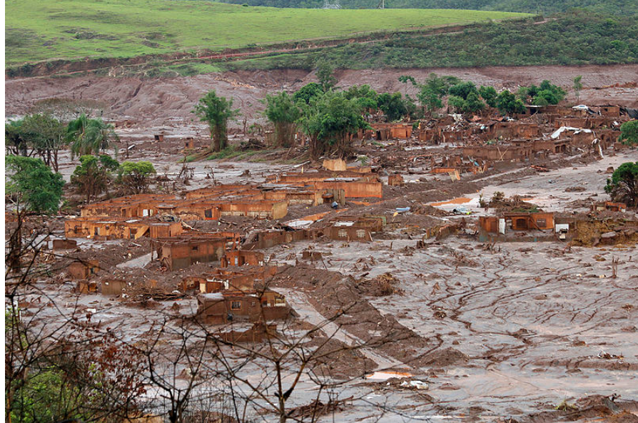
Figura 18 - Rompimento da barragem de Fundão. Fonte: Rogério Alves, 2015.
