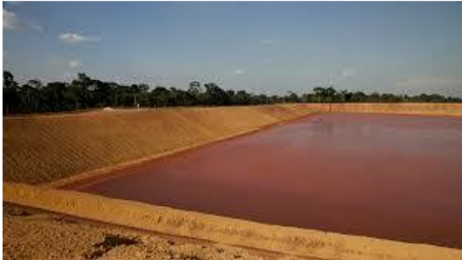
Figura 15 - Lagoa de Sedimentação. Fonte: Brelaz, 2013.
