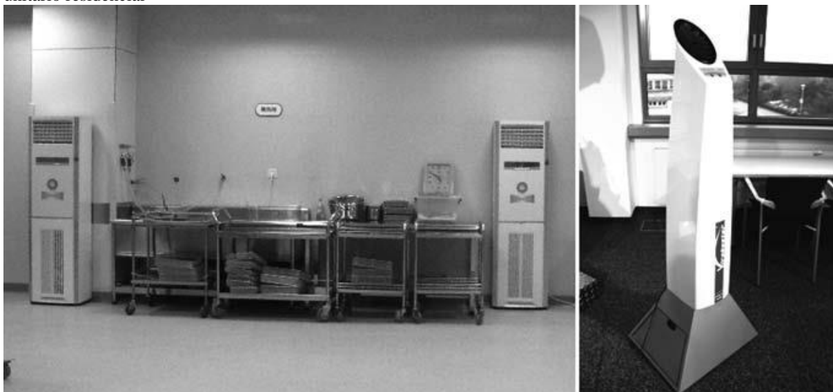
Figura 10 - Na esquerda um sistemas autônomos para estabelecimentos de saúde. Na direita Sistema UV unitário residencial
