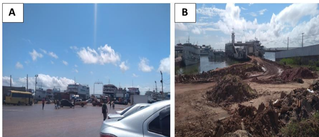
Figura 11– Infraestrutura no Porto D.E.R (A) e entulhos na área (B).
