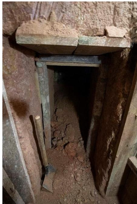
Figura 2-20 Abertura de galeria interna para retirada das rochas com ouro.
