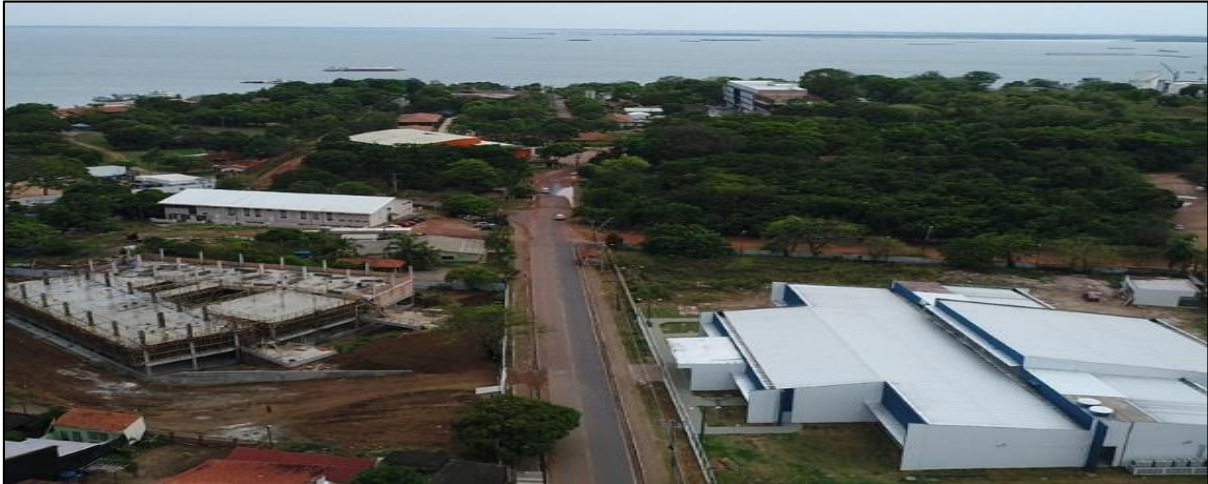
Figura 2 - Obras - Unidade Tapajós
