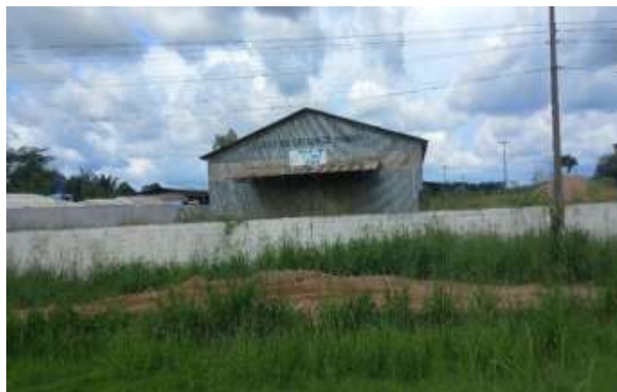
Figura 2 – Armazém da CIBRAZÉM de Machadinho d'Oeste vista externa
