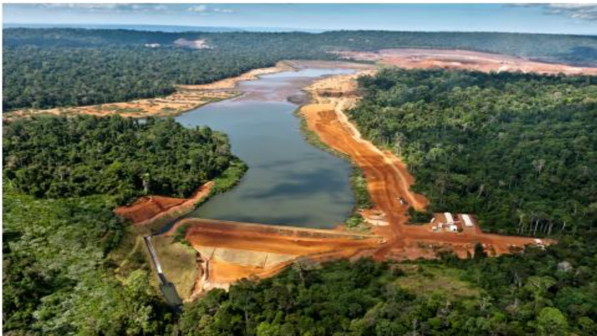
Figura 14. Vista aérea da barragem do Kalunga, Carajás PA, já desativada (Fonte: ANDRADE e JÚNIOR, 2013).
