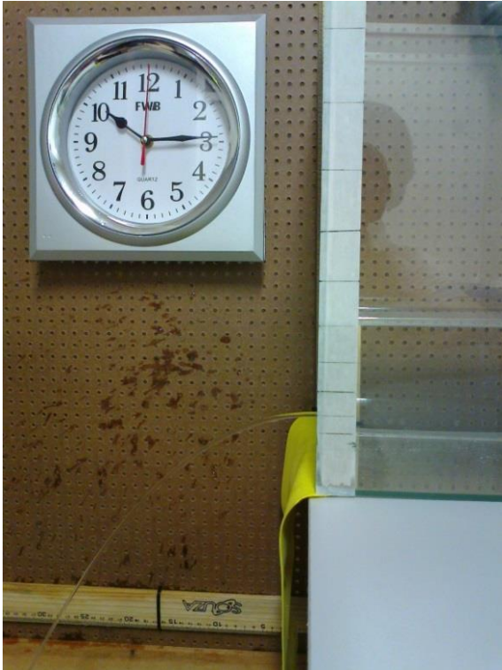
Fotografia 15 – Sete minutos de escoamento
