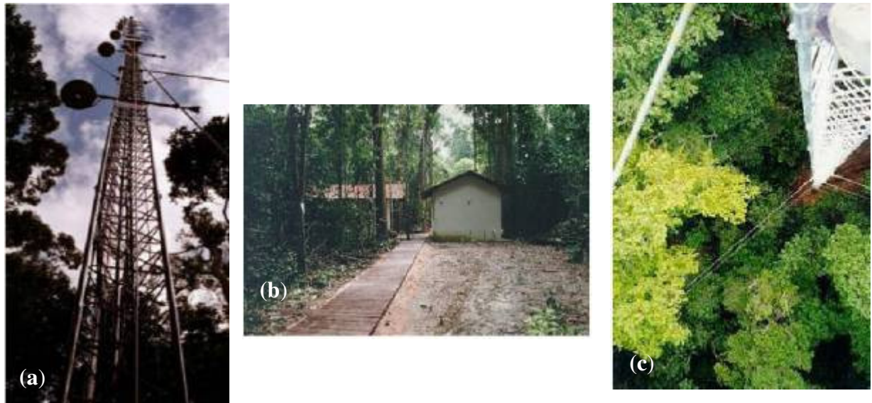
Figura 13 – Oeste do Pará (Santarém) – km 67, torre do sitio da floresta primária: a) perfil da torre; b) abrigo dos instrumentos de controle climáticos e c) visão da torre.
